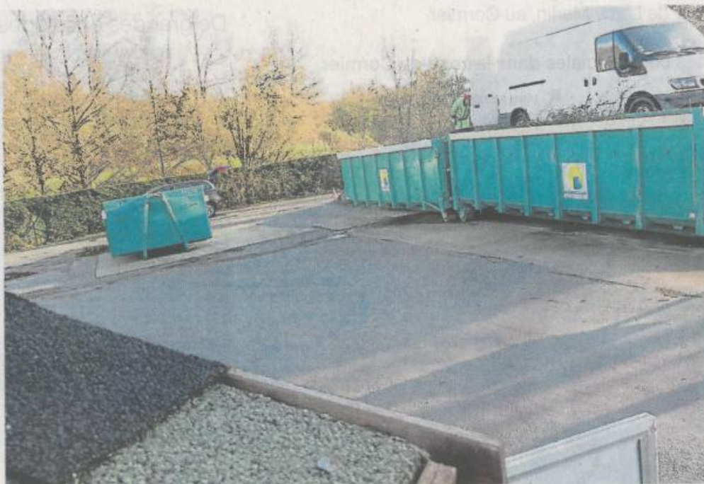
L'éco-point de La Tessoualle est l'un des quatre qui sont conservés pendant la construction des déchèteries rurales.
