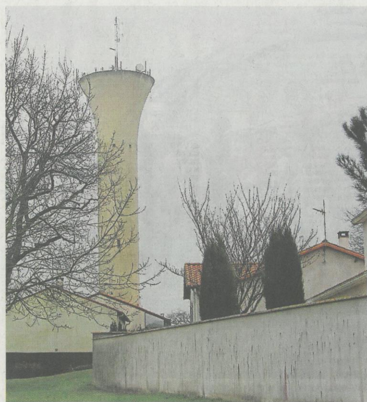
Le château d'eau de Saint-Léger-sous-Cholet accueille déjà onze faisceaux hertziens et trois antennes radio.
