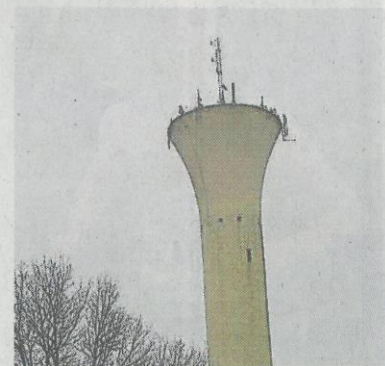
Des modifications vont être apportées aux installations d'antennes relais..
