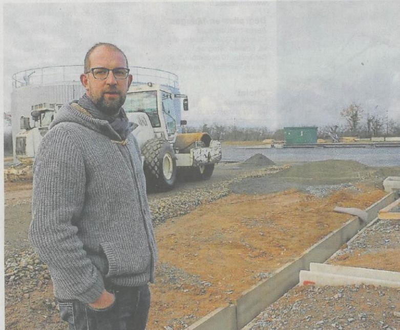
Christian Chupin, l'agriculteur qui préside Bio-Méthane-Seg. Au sol, c'est par des canalisations enfouies dans cette tranchée en béton que le gaz produit par l'usine de méthanisation rejoindra le réseau.
