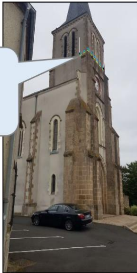
Raccordement antennes amphénoles 1 Elévation sud est
